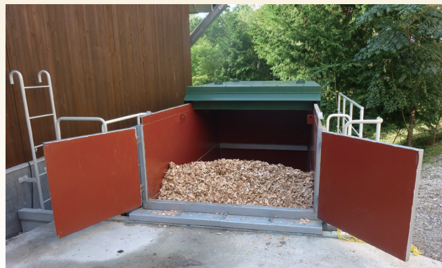
燃料チップの受入・排出装置への応用(固定式)
