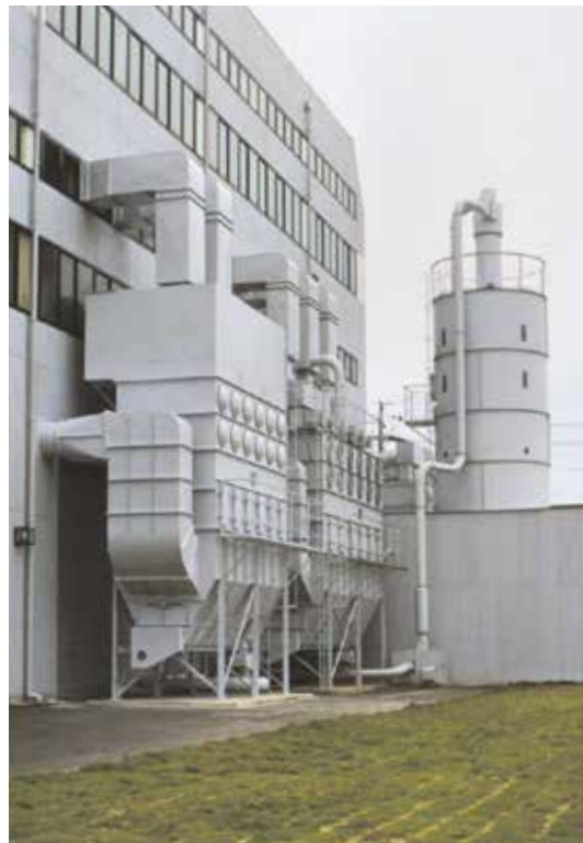
BFR 3×6 : 37 kW BFR4×6 : 45 kW 全自動プレカット工場
